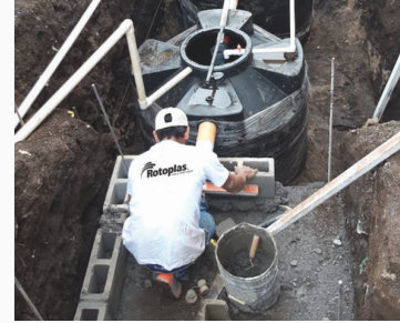
Figura 7. Relleno de la excavación para la instalación del Biodigestor Autolimpiable Plus+ .
