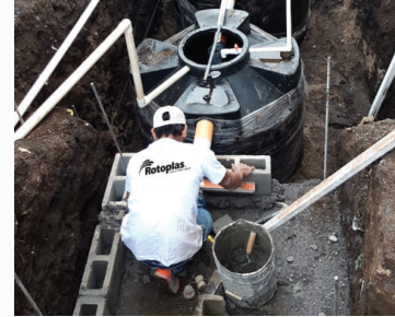
Figura 7. Relleno de la excavación para la instalación del Biodigestor Plus+ .
